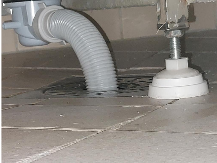
Membran, tettesjikt og sluk (i gulv og vegger) ink. rørgjennomføringer. - [Gulvsluk under dusjkabinett på bad.]
